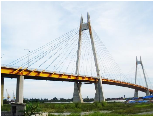
Thi công chống thấm cầu
