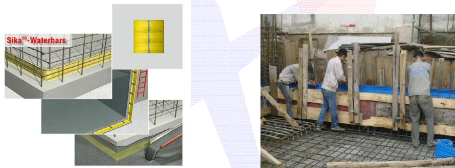
Hình ảnh thi công bằng cân nước tầng hầm
