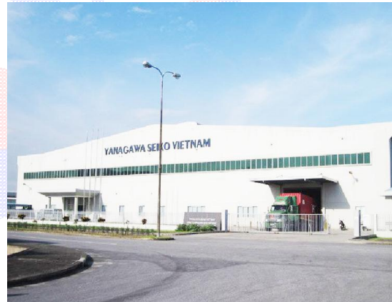
Thi công chống thấm nhà công nghiệp
