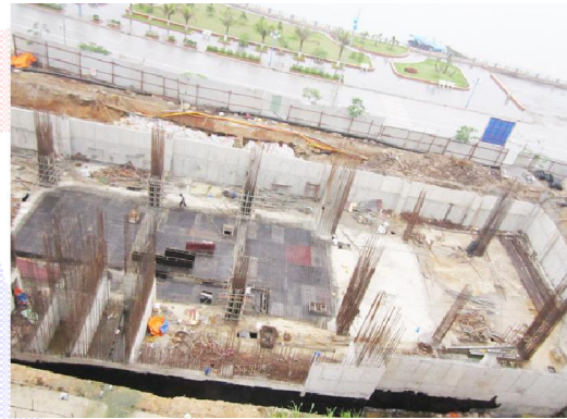
Thi công chống thấm tầng hầm
