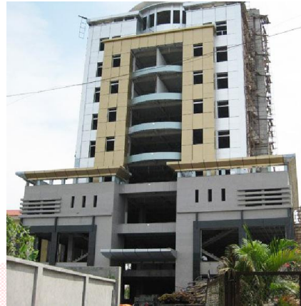
Tòa nhà điều hành Công ty TNHH Thành Đức
