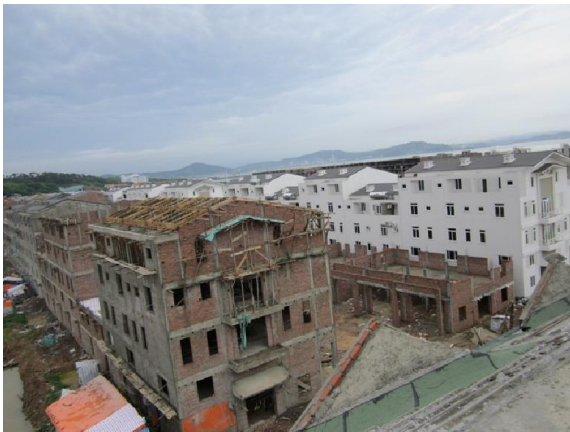
Thi công chống thấm khu biệt thự cao cấp
