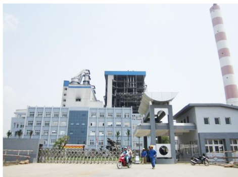
Nhà máy Nhiệt điện Hải Phòng
